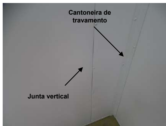
Fotografia 5 – Detalhes das juntas entre as placas e cantoneira de travamento
